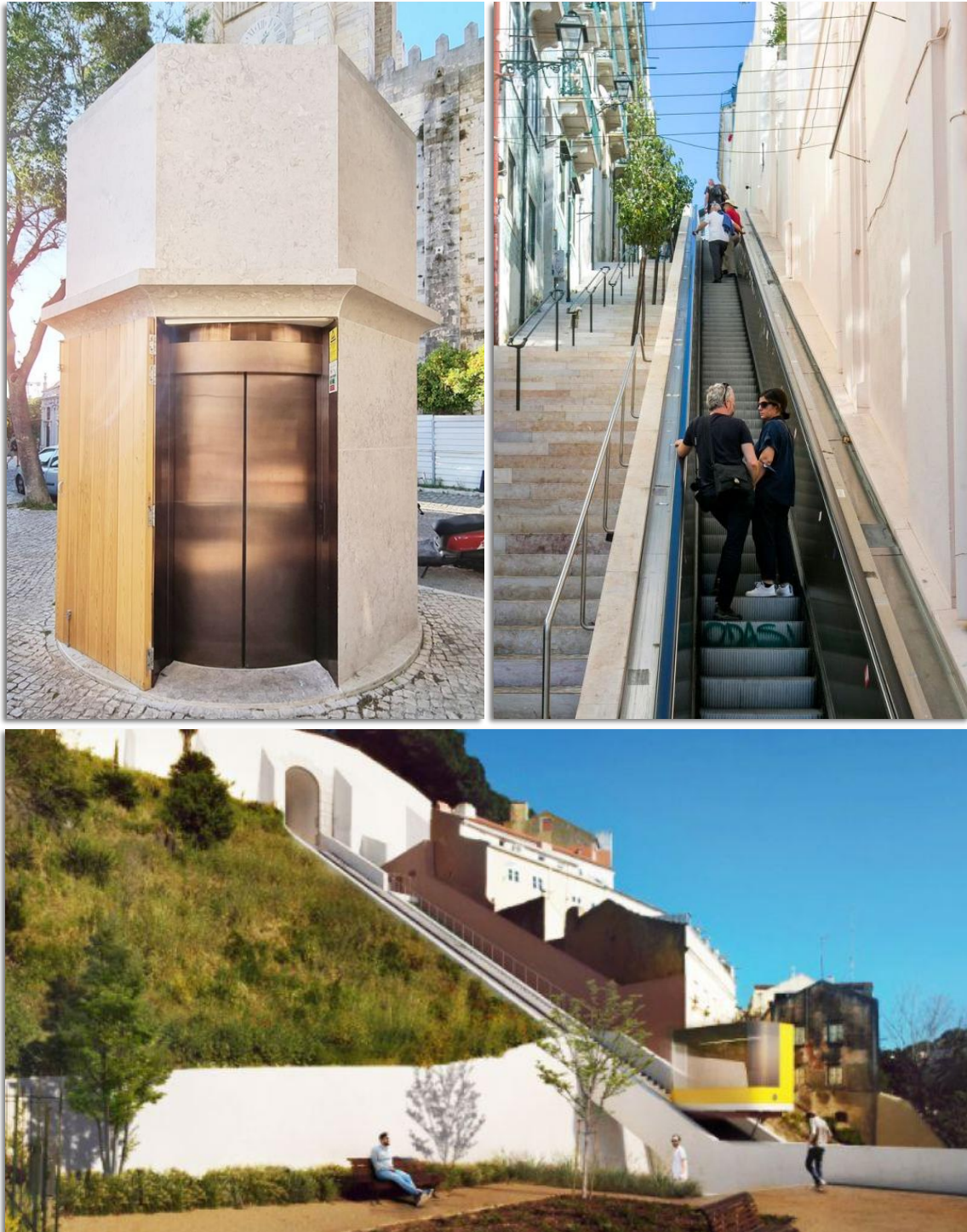
FIGURA 4-1 ELEVADOR DA SÉ, ESCADAS ROLANTES DA MOURARIA E PERSPETIVA FUTURA DO FUNICULAR DA GRAÇA
