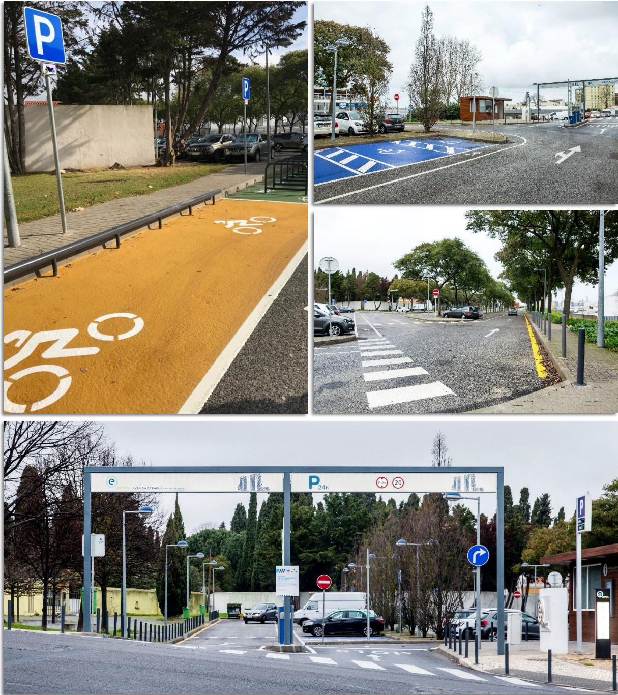
Figura 2.6 Parque de estacionamento na Avenida de Pádua
