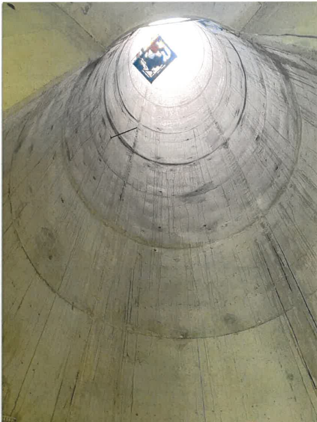
Figura 3-4 Poço do Elevador da Sé
