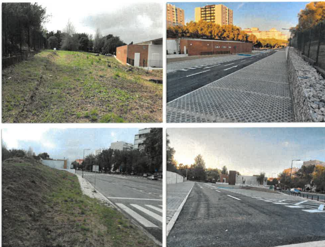
Figura 2-1 Requalificação para o estacionamento de parcela contígua à Rua José Sebastião e Silva - antes e depois da intervenção
