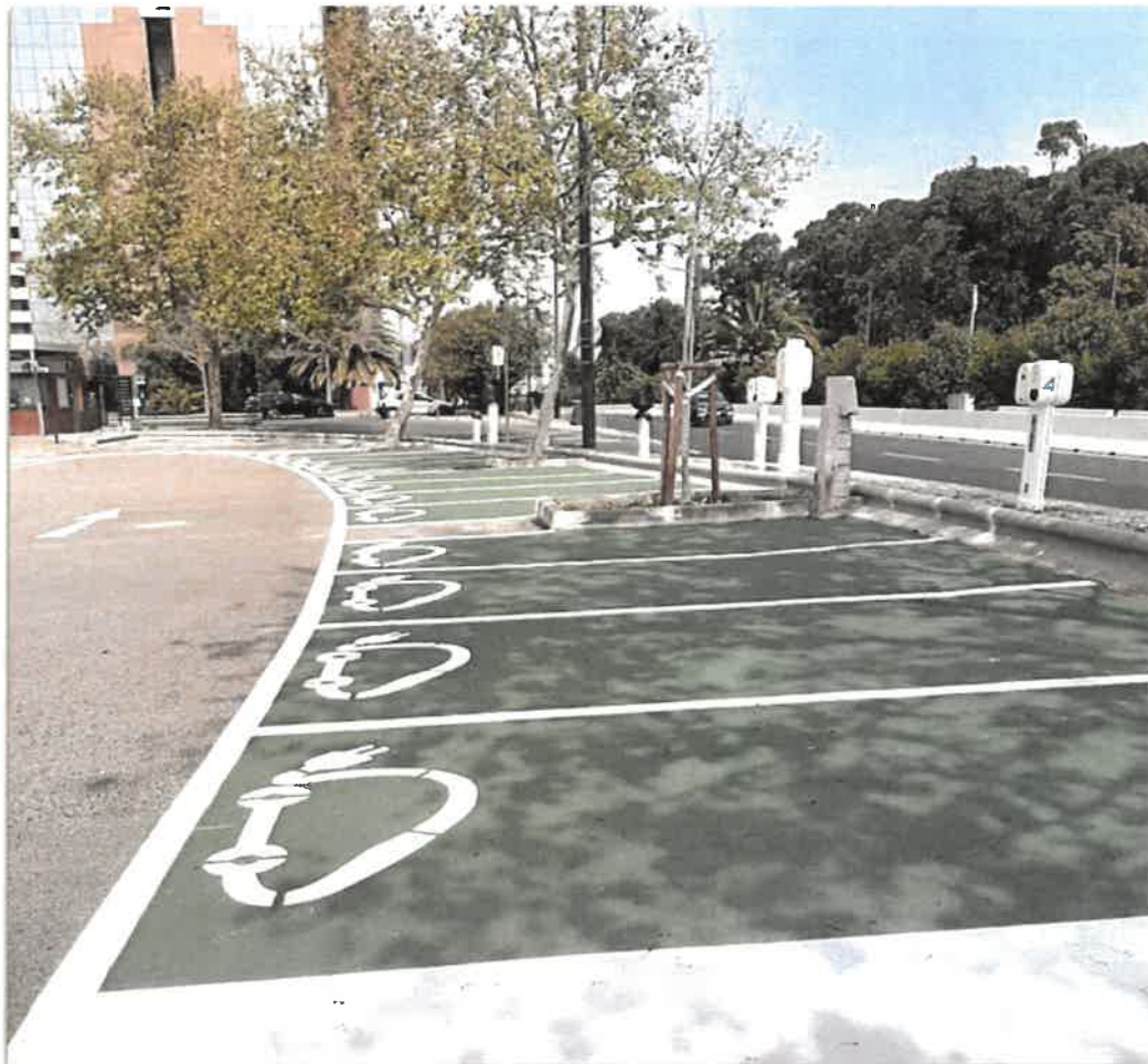
Figura 3-8 Pontos de Carregamento de Veículos Elétricos no Parque dos Combatentes
