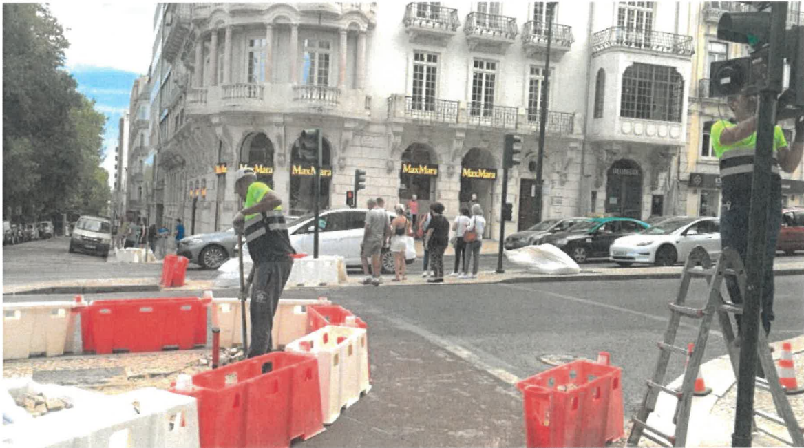
Figura 4-15 Trabalhos em curso na Avenida da Liberdade
