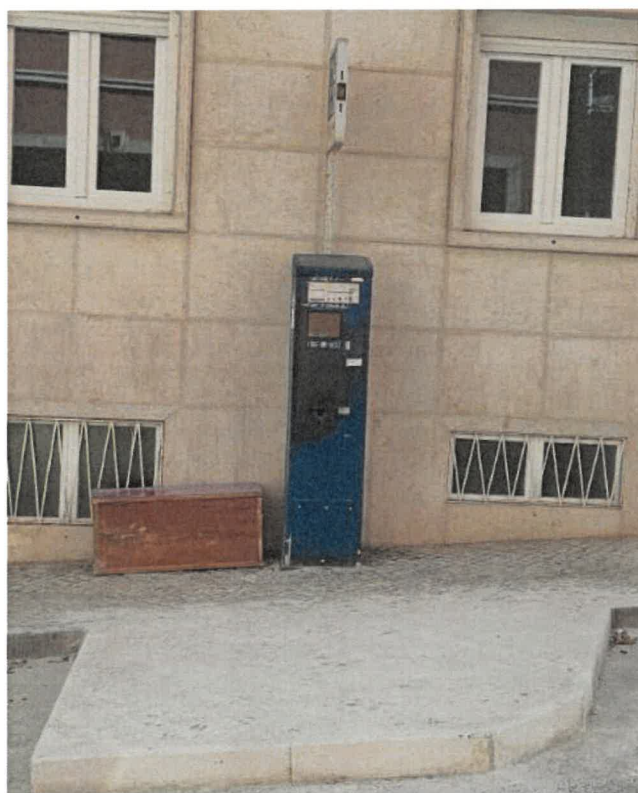
Figura 4-4 Implementação de "ilha" para parquímetro
