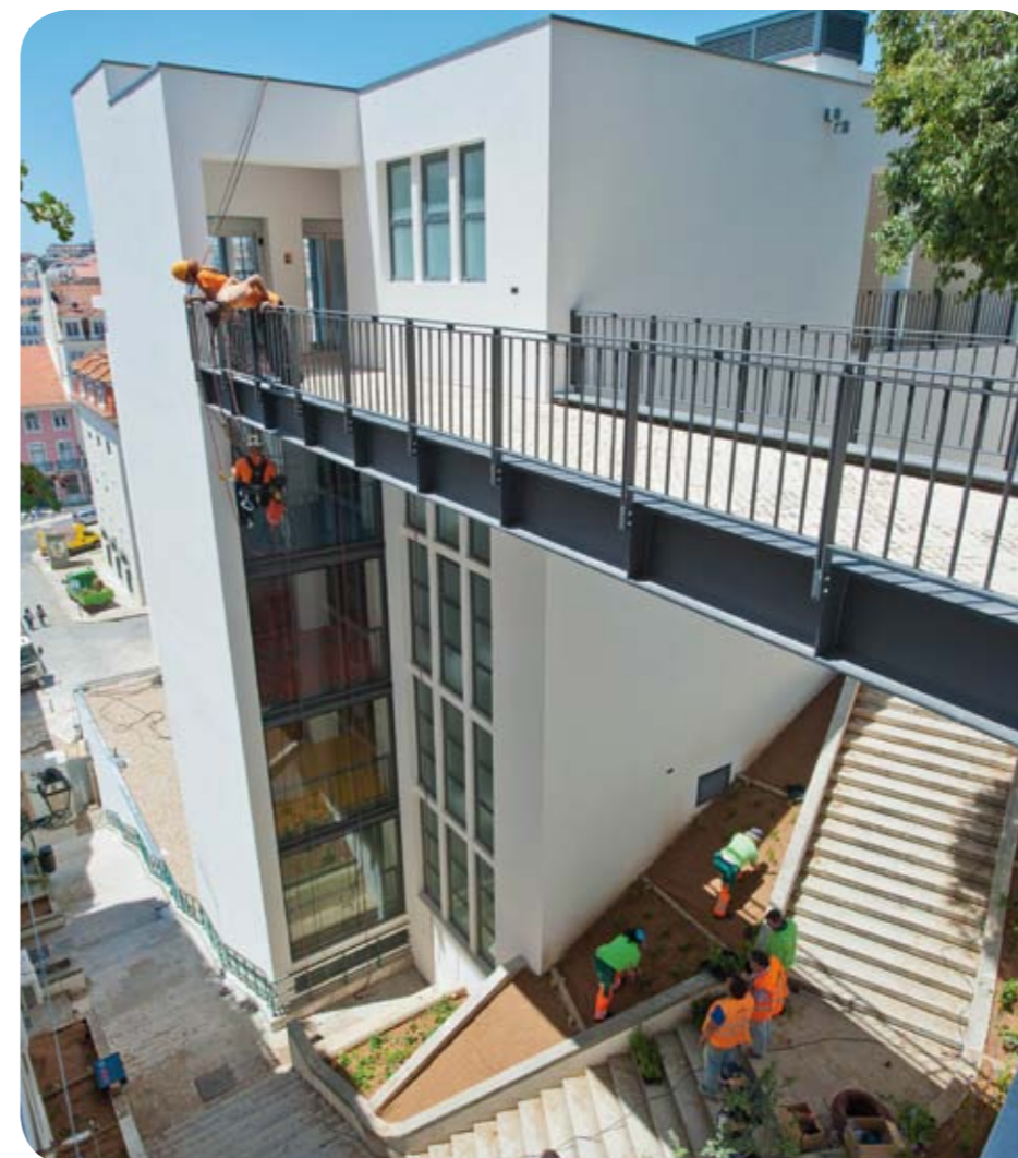
Acabamentos Exteriores da Construção do Parque do Chão do Loureiro
