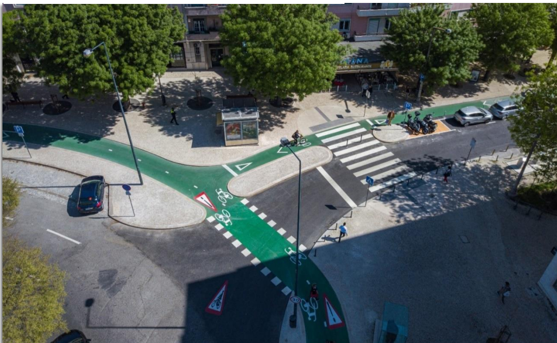
FIGURA 3-7 PRAÇA DE LONDRES - PORMENOR DE CONVÍVIO DE MODOS - CICLOVIA, PASSEIOS ALARGADOS, BOLSA DE MOTOCICLOS E ESTACIONAMENTO AUTOMÓVEL NA VIA PÚBLICA
