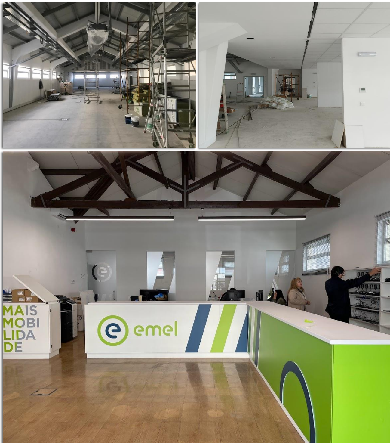
FIGURA 6-1 TRABALHOS DE ADAPTAÇÃO DAS NOVAS INSTALAÇÕES EM CABO RUIVO
