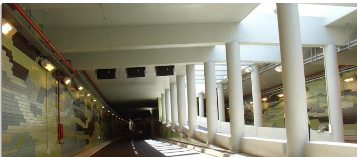
FIGURA 3-18 TÚNEL DO MARQUÊS DE POMBAL
