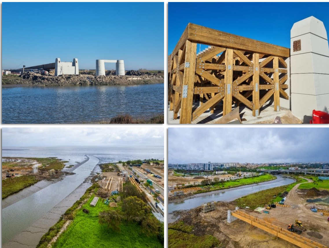
FIGURA 3-9 PONTE CICLOPEDONAL SOBRE O RIO TRANCÃO - OBRAS EM CURSO
