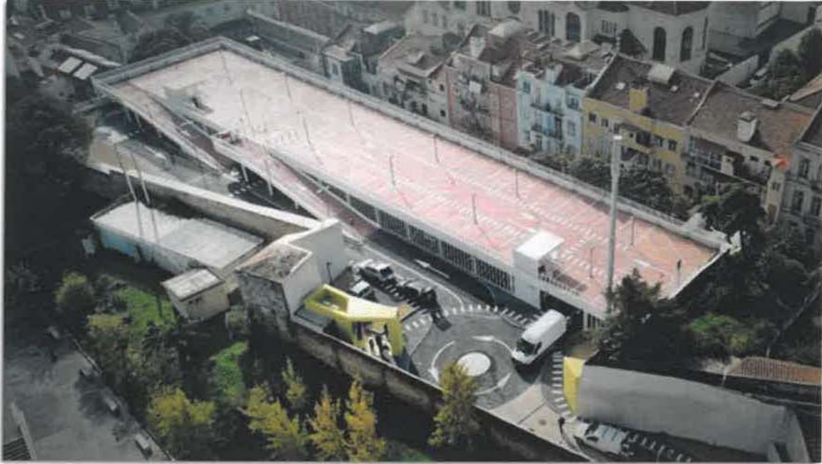
Figura 1.8 Novo parque de estacionamento da Graça
