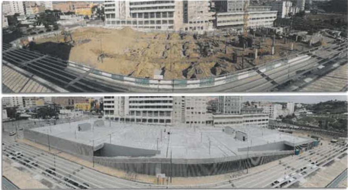
Figura 1.9 Novo parque de estacionamento da Rua Manuel Gouveia (em construção e já concluído)
